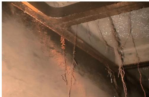
Рисунок 1.2 – Биокоррозия элементов конструкций
