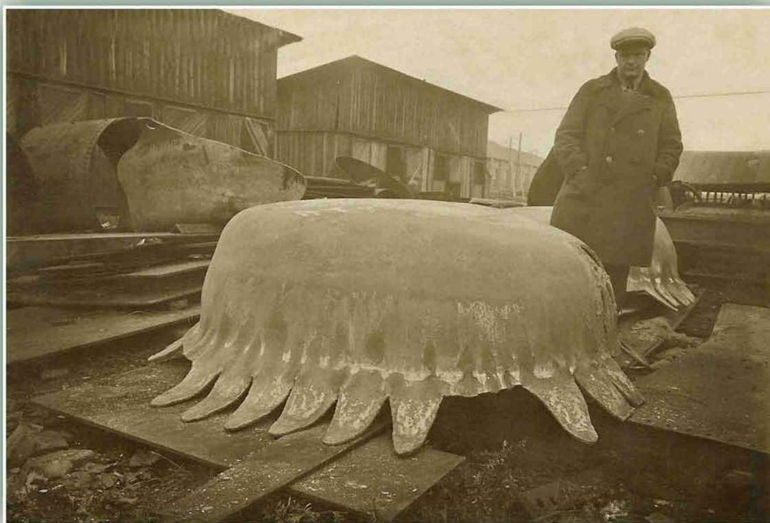
Н.М. Скляров осматривает штамповку броневой стали
